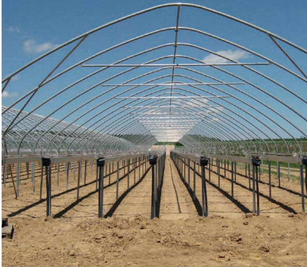
Folientunnel haben eine einfachere Konstruktion und in der Regel gibt es keine Statik des Herstellers. Sind die GV-Mindestanforderungen an die Bauweise jedoch erfüllt, können auch die Folientunnel gegen die Gefahren Hagel, Sturm inklusive sonstige Elementargefahren und Feuer versichert werden. Schäden verursacht durch Schnee- und Eisdruck sind mit bestimmten Einschränkungen eingeschlossen (siehe Tabelle auf der rechten Seite).
