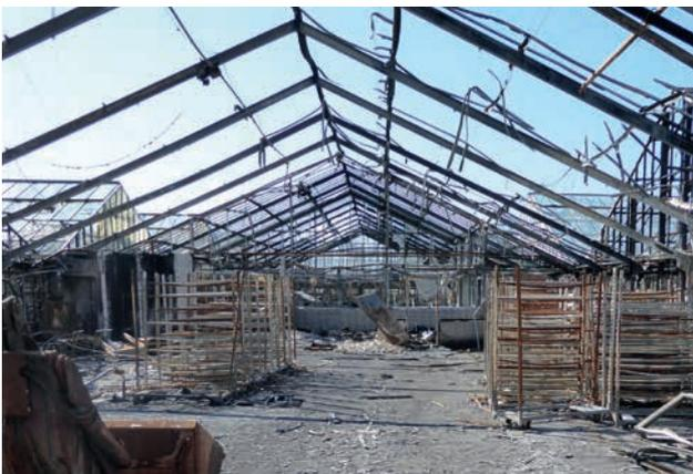
Vermutlich durch einen technischen Defekt in der Lagerhalle eines norddeutschen Topfpflanzenbetriebs kam es im März, angefeuert durch die hohe Brandlast, zu einem Großbrand. Die Halle war mit Plexiglas eingedeckt und enthielt reichlich Kartonagen und Plastiksteigen. Hierdurch konnte das Feuer schnell auf die benachbarten Gewächshäuser übergreifen. Der versicherte Gesamtschaden belief sich auf 700.000 €.
