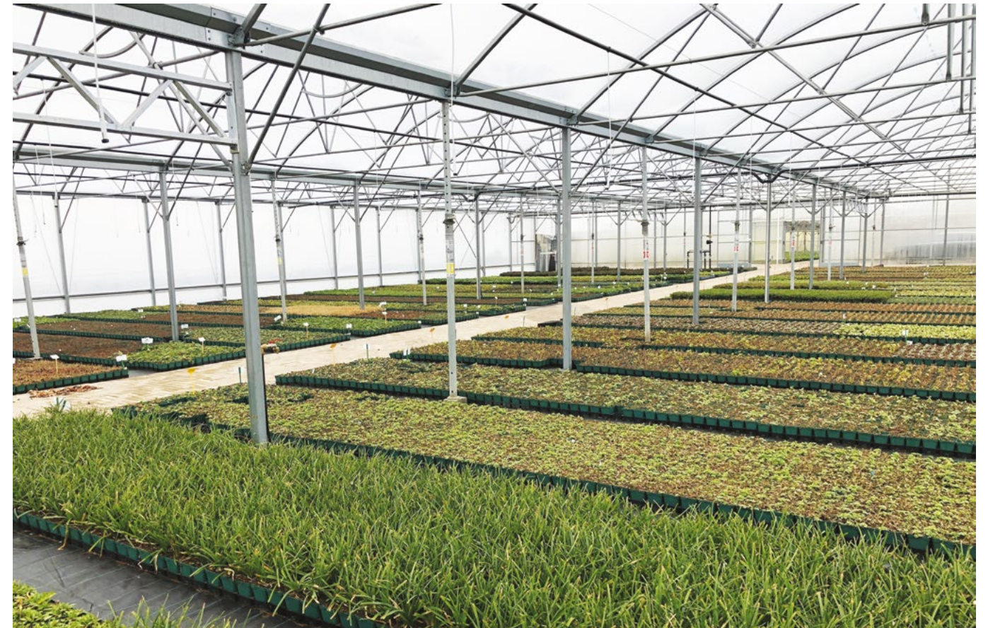
Anfang Februar 2021 verbaute unser Mitgliedsbetrieb Schachtschneider Stauden nach einer Unwetterwarnung 250 Metallstützen.
