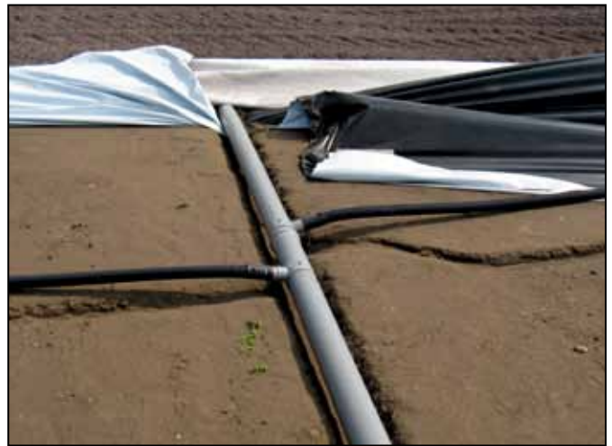
Bild 6: Aufbau einer geschlossenen Kulturfläche; Unterboden, Entwässerungsleitung, Geotextil, Lava.
