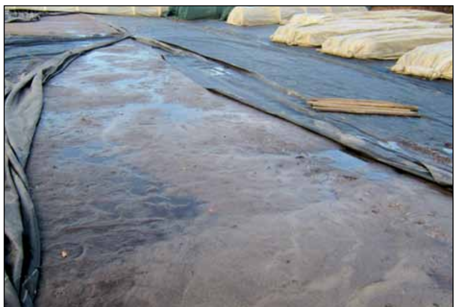
Bild 2: Rinnen- und Senkenbildung unter der Gewebefolie
